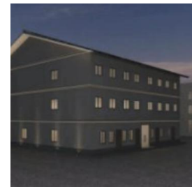
西成區舊式建築物改裝
